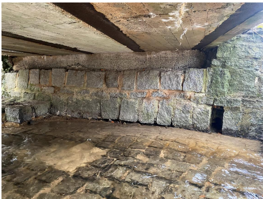
Fot. 7. Widoczna strefa podmostowa i przyczółek lewobrzeżny
