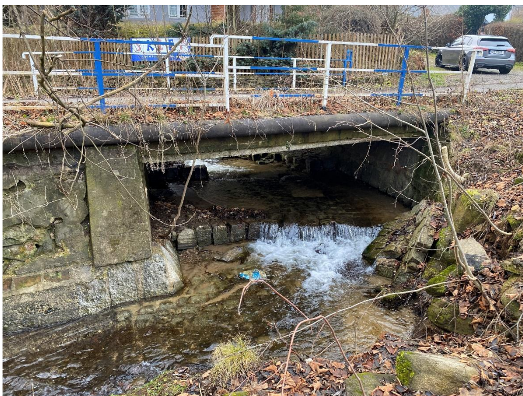
Fot. 3. Obiekt mostowy od strony wody dolnej
