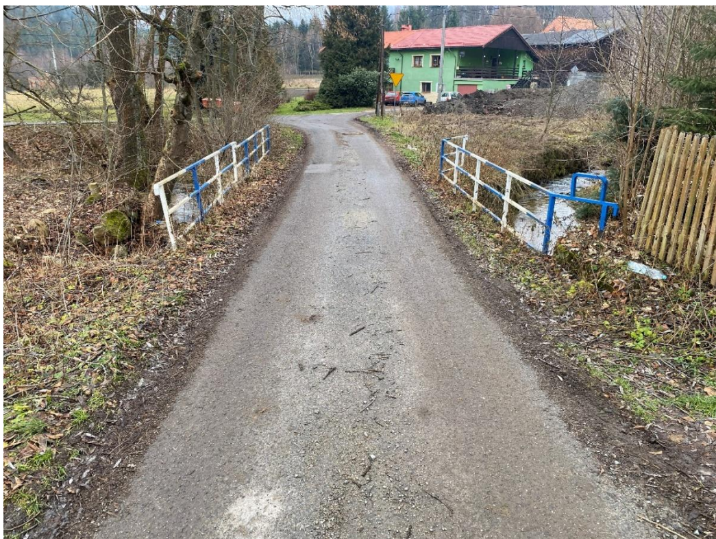
Fot. 2. Obiekt mostowy w stronę drogi powiatowej
