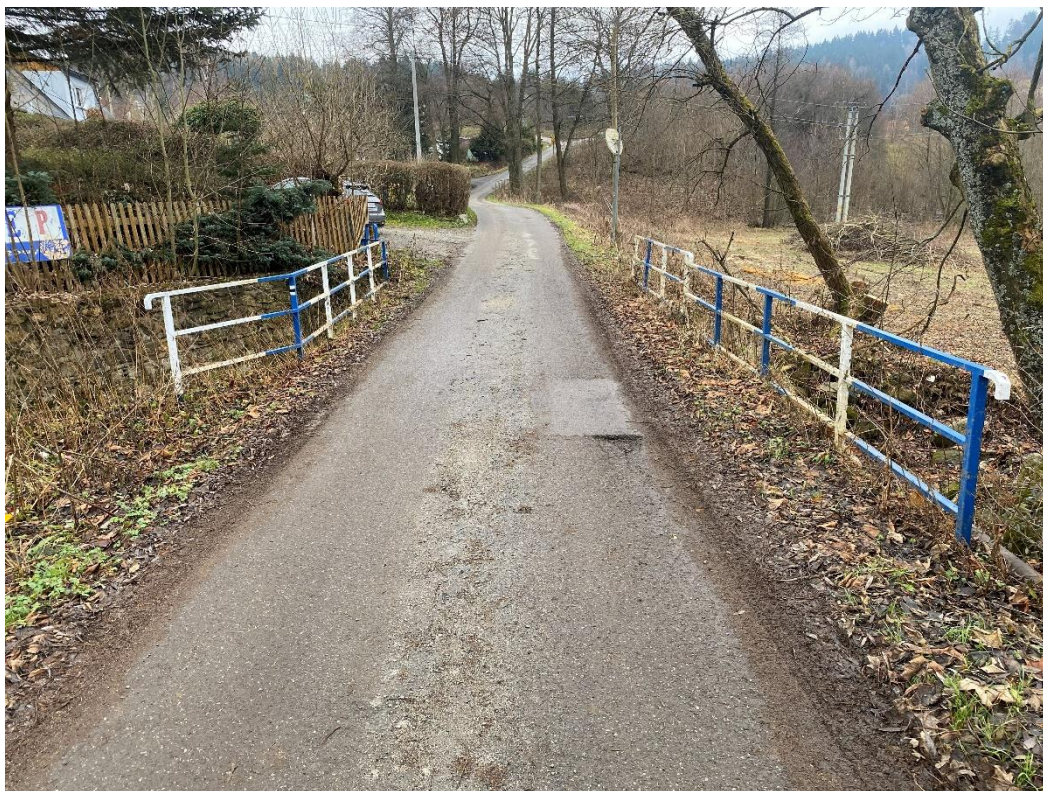
Fot. 1. Obiekt mostowy od strony drogi powiatowej
