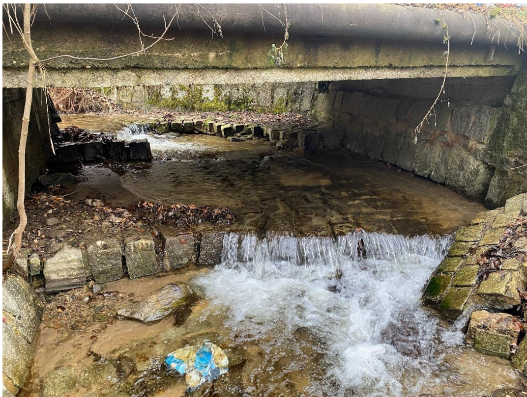
Fot. 6. Widoczna strefa podmostowa
