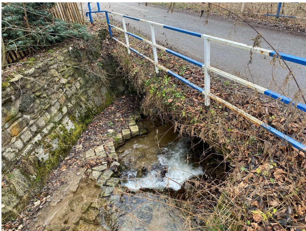
Fot. 4. Obiekt mostowy od strony wody górnej
