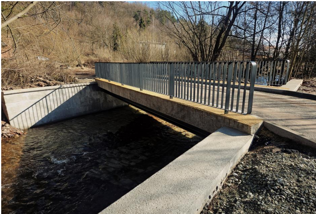
Most po odbudowie w 2025 r.
