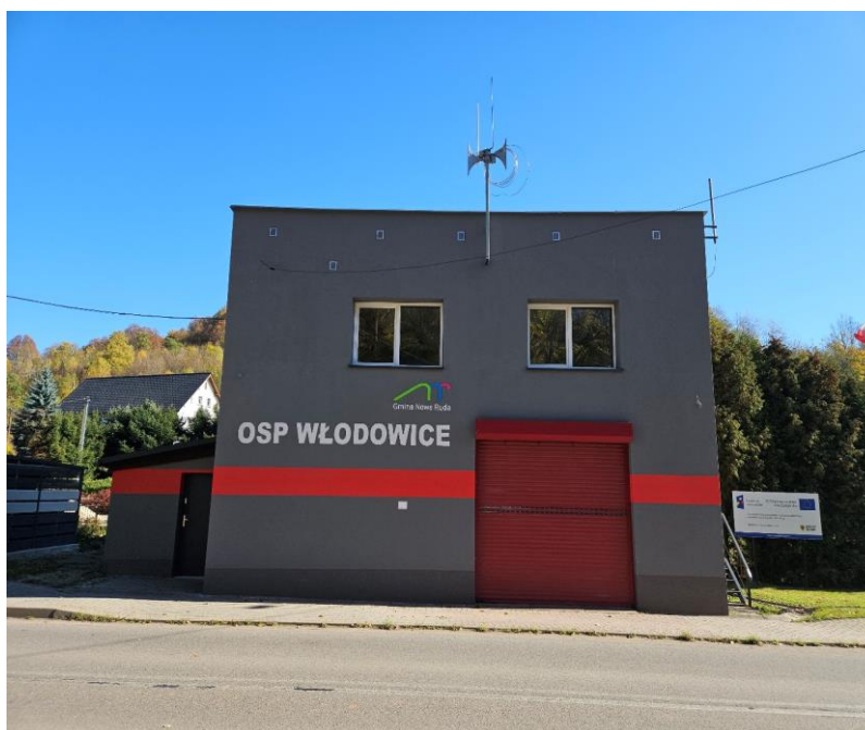
Termomodernizacja budynku OSP Włodowice
