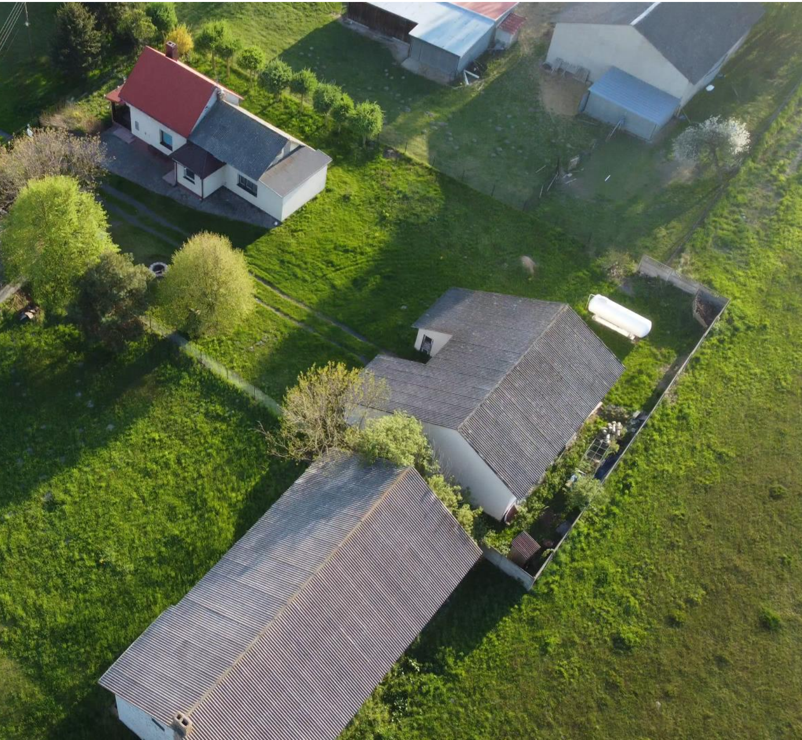
Fot. 1. Wykorzystanie wyrobów azbestowych jako pokrycia dachowe.
