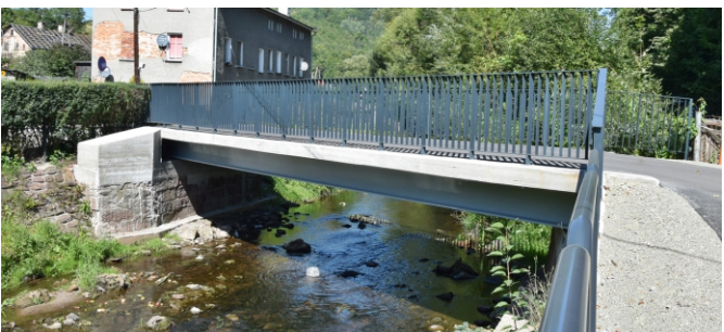
Fot. Wyremontowany most gminny we Włodowicach.
