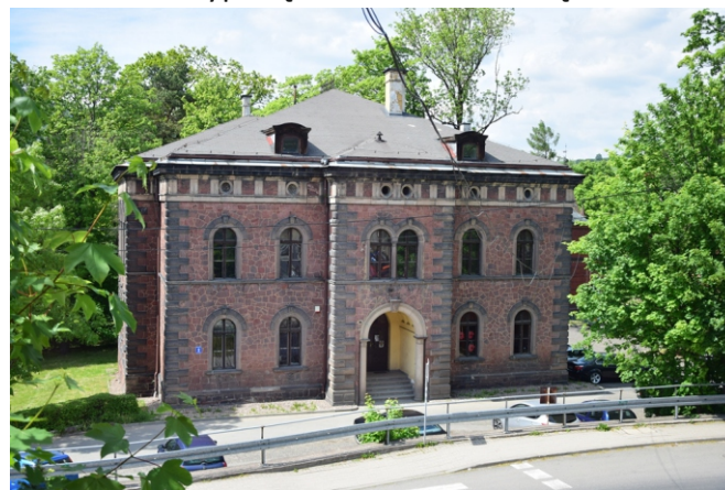
Fot. Budynek dawnego sądu, pozyskany w formie darowizny będzie nową siedzibą urzędu oraz Gminnego Ośrodka Pomocy Społecznej.
