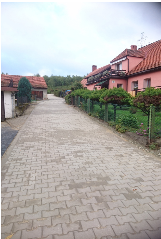
Fot. Nowa nawierzchnia drogi gminnej w Jugowie.
