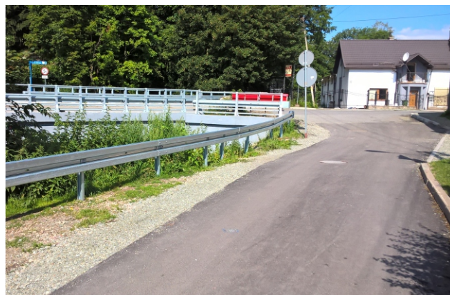
Fot. Przy drodze gminnej w Ludwikowicach Kł., gmina zamontowała bariery energochłonne.
