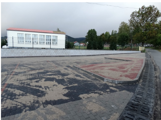
Fot. Wybudowany parking gminny w Jugowie.
