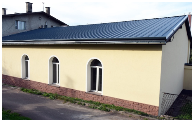
Fot. Budynek sali gimnastycznej w Woliborzu po przeprowadzonej termomodernizacji.
