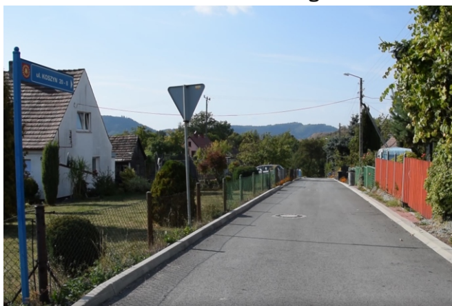
Fot. Nowa nawierzchnia drogi gminnej w Sołectwie Koszyn.
