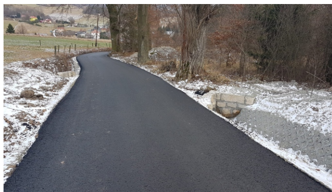
Fot. Nowa nawierzchnia drogi gminnej w Jugowie, ul. Brzozowa.
