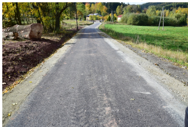
Fot. Nowa nawierzchnia drogi gminnej w Bartnicy - Złota Woda.
