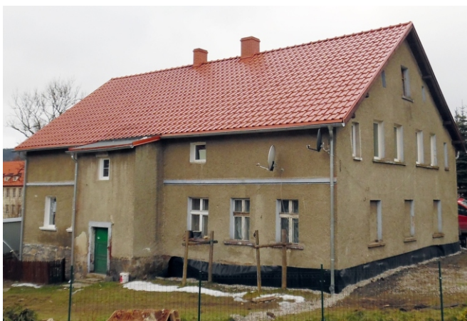
Fot. Dach wyremontowany z budżetu gminy na budynku komunalnym w sołectwie Sokolec.
