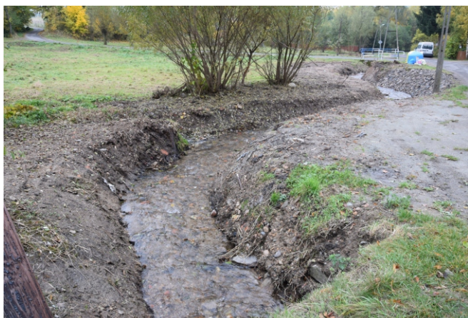
Fot. Konserwacja rowu przy ul. Pniaki w Jugowie.
