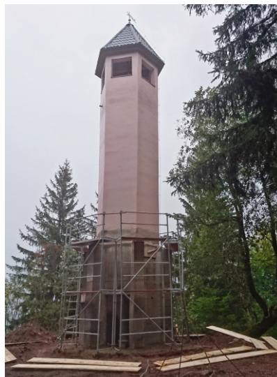
Fot. Wieża widokowa na Górze Włodzickiej w trakcie odbudowy.
