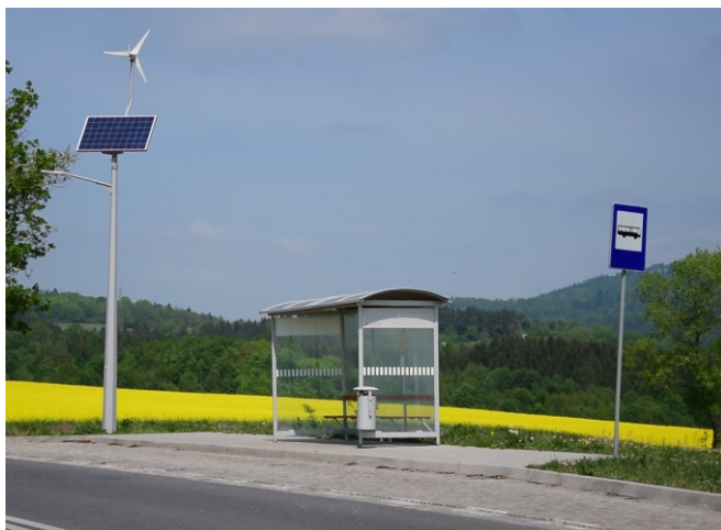
Fot. Nowa wiat przystankowa i lampa hybrydowa w Bożkowie, przy drodze wojewódzkiej.
