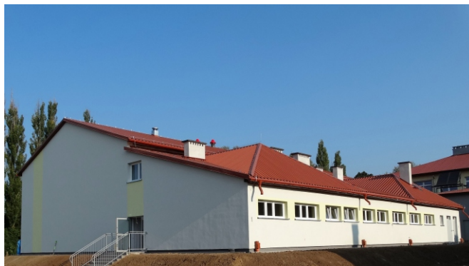
Fot. Nowa sala gimnastyczna dobudowana do szkoły podstawowej w Bożkowie.
