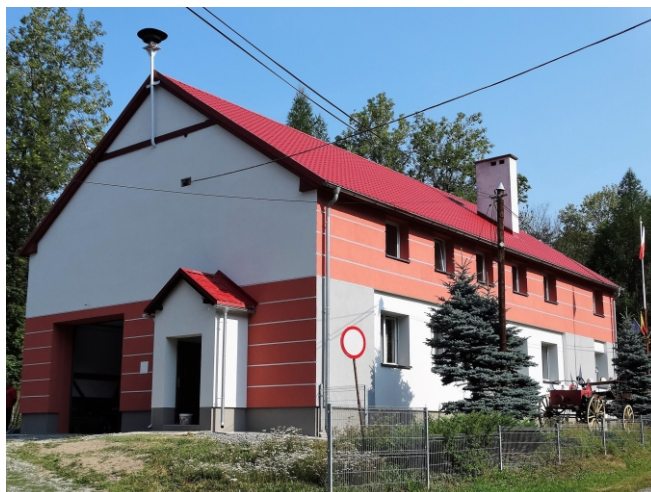
Fot. Budynek sali wiejskiej i remizy w Nowej Wsi Kł. po przeprowadzonej termomodernizacji.
