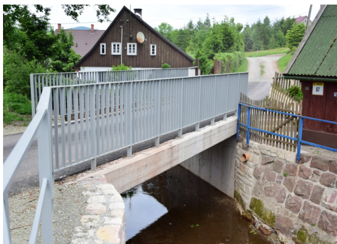
Fot. Wyremontowany most gminny w Świerkach.
