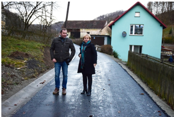
Fot. Nowa nawierzchnia drogi gminnej w Czerwieńczycach.
