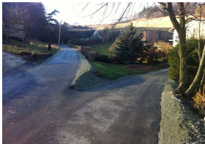
Fot. Nowa nawierzchnia drogi gminnej w Dzikowcu.
