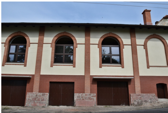
Fot. Budynek Sali Myśliwskiej w Woliborzu po termomodernizacji.
