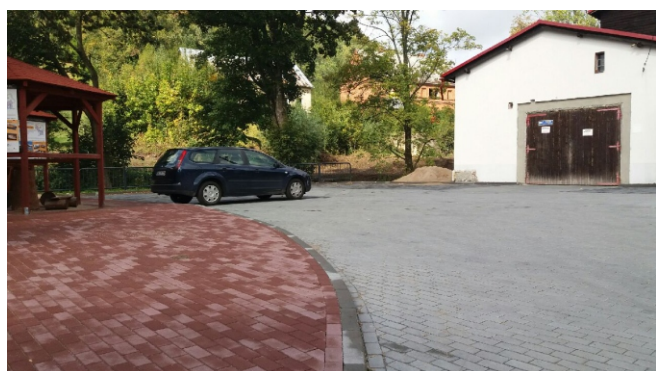
Fot. Wybudowany parking gminny w Sokolcu.
