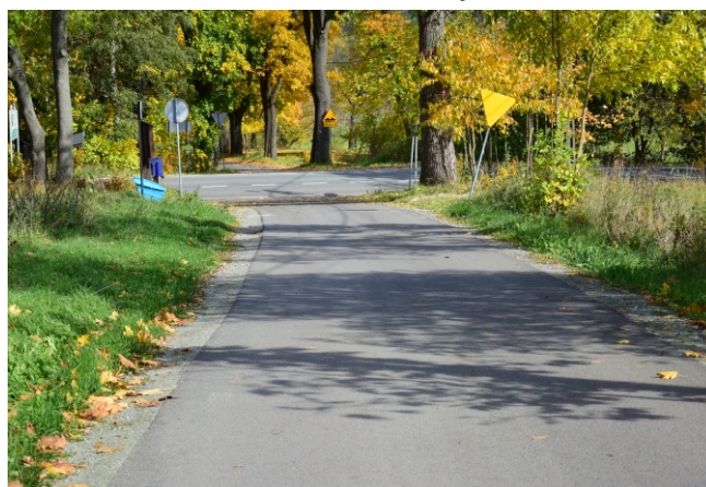
Fot. Nowa nawierzchnia drogi gminnej w Bartnicy.
