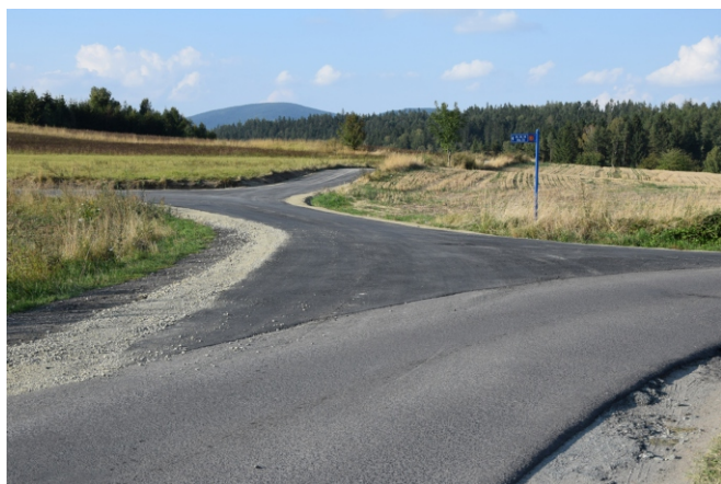
Fot. Nowa nawierzchnia drogi gminnej w Dzikowcu - Kolonii.
