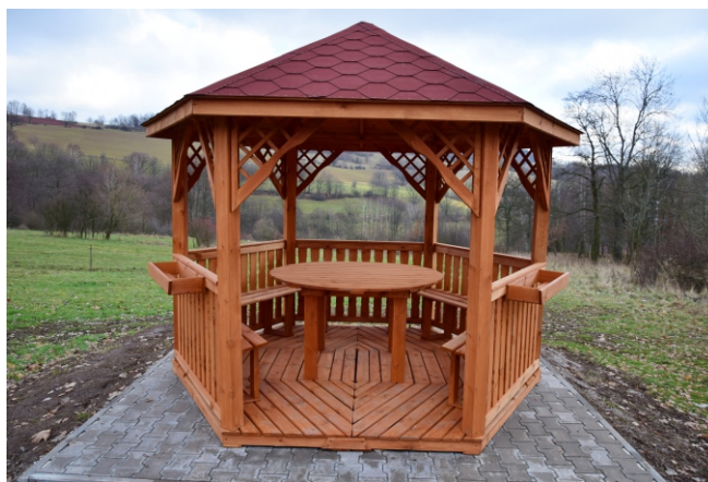
Fot. Wiata rekreacyjna w Sokolicy, postawiona w ramach Funduszu Sołeckiego.
