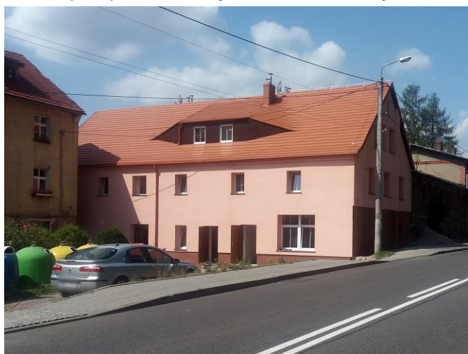
Fot. Budynek komunalny w Ludwikowicach Kł. po przeprowadzonej termomodernizacji.
