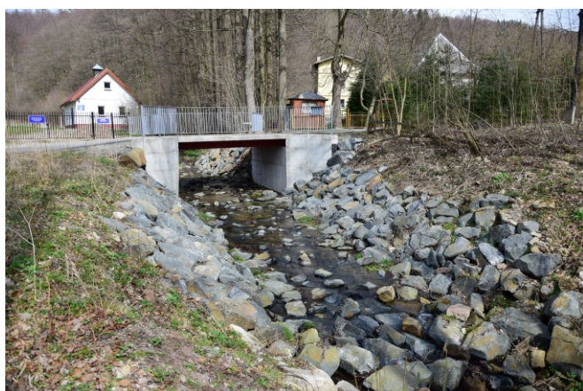
Fot. Wyremontowany most gminny w Woliborzu.
