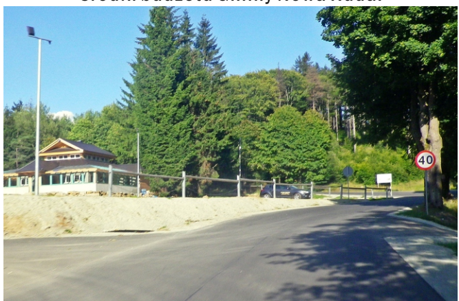
Fot. Nowa nawierzchnia drogi powiatowej w Jugowie (od Przełęczy Jugowskiej do Sokolca), w której remont zaangażowane były środki budżetu Gminy Nowa Ruda.
