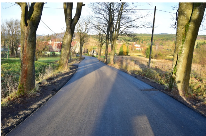
Fot. Nowa nawierzchnia drogi powiatowej w Bartnicy, w której remont zaangażowane były środki budżetu Gminy Nowa Ruda.
