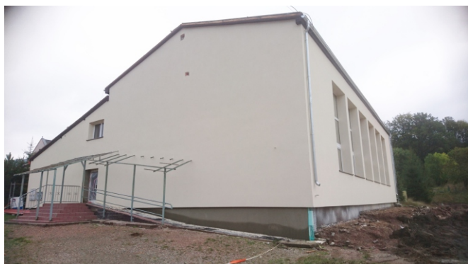
Fot. Budynek sali gimnastycznej w Jugowie w trakcie termomodernizacji.
