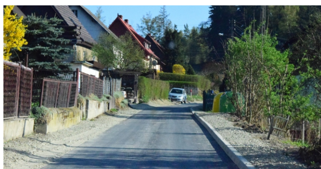
Fot. Nowa nawierzchnia na ul. Osiedle w Przygórzu położona po wykonaniu sieci kanalizacyjnej.
