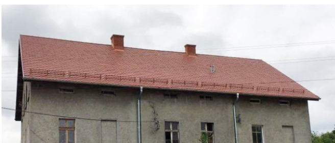
Fot. Dach wyremontowany z budżetu gminy na budynku komunalnym w Dzikowcu.
