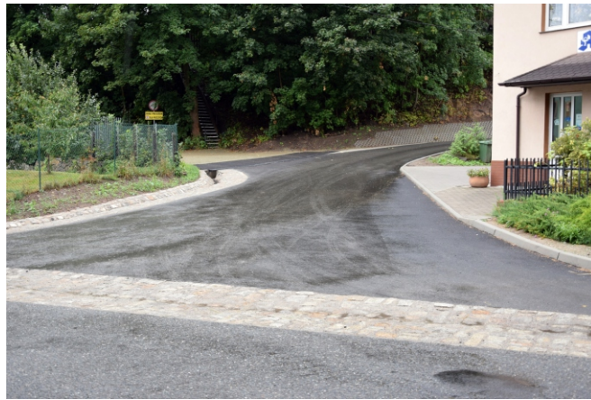
Fot. Nowa nawierzchnia drogi gminnej w kierunku tartaku w Jugowie.
