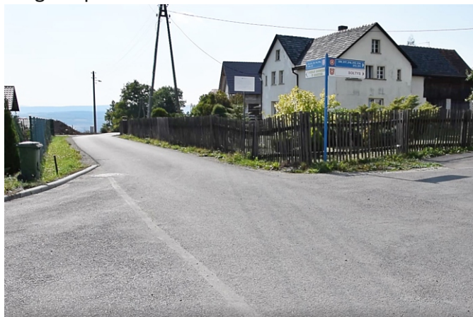
Fot. Nowa nawierzchnia drogi gminnej na Koszynie.
