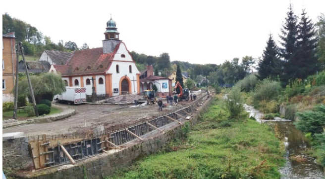
Fot. Parking gminny we Włodowicach w trakcie budowy.
