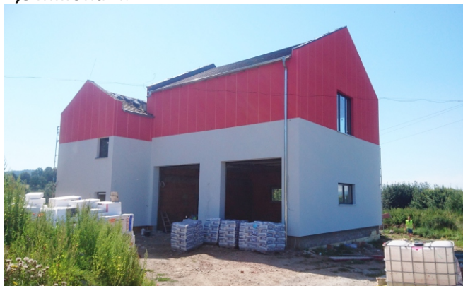
Fot. Nowy budynek Ochotniczej Straży Pożarnej w Bożkowie.
