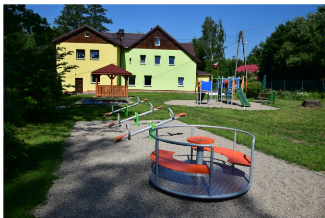
Fot. Budynek przedszkola samorządowego w Woliborzu po termomodernizacji.
