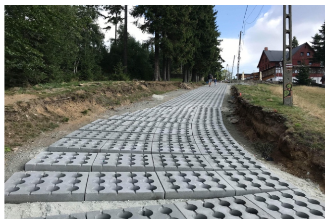
Fot. Nowa nawierzchnia drogi gminnej w Sokolcu.
