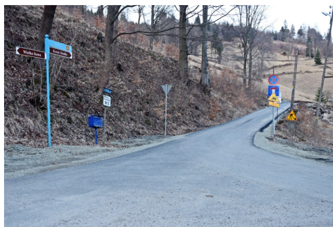
Fot. Nowa nawierzchnia drogi gminnej w Sokolcu.
