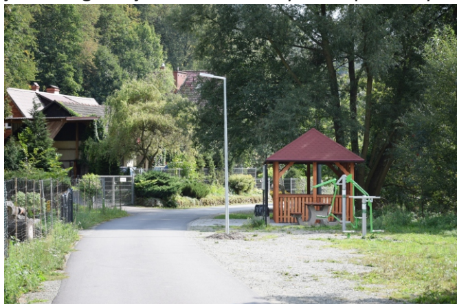
Fot. Nawierzchnia ścieżki rowerowej we Włodowicach, wykonane oświetlenie całej trasy, urządzenia siłowni plenerowej i infrastruktura towarzysząca - wiaty do odpoczynku, stoły oraz tablice informacyjne.
