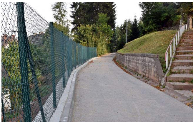
Fot. Nowa nawierzchnia drogi gminnej w Woliborzu, obok sali gimnastycznej.
