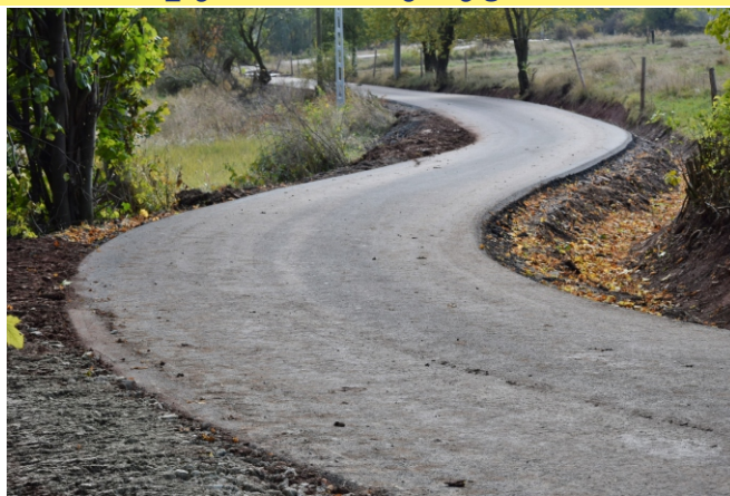
Fot. Nowa nawierzchnia drogi gminnej w Krajanowie-Bytkowicach.
