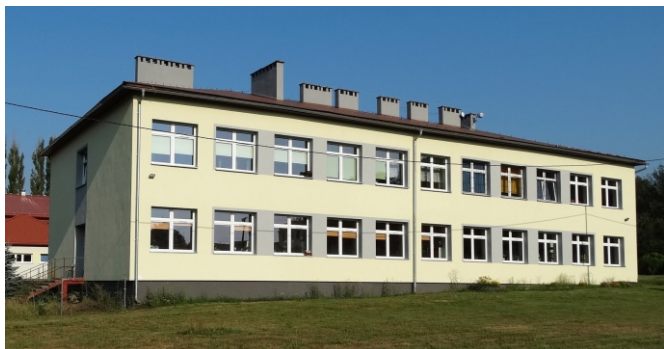
Fot. Budynek szkoły podstawowej w Bożkowie po przeprowadzonej termomodernizacji.
