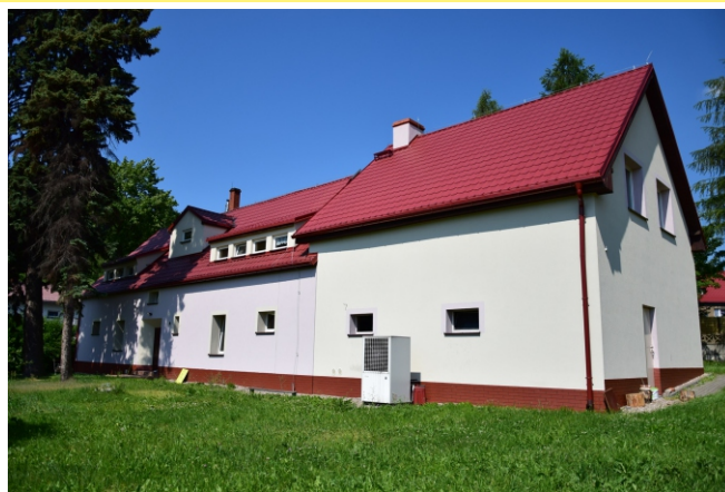
Fot. Budynek przedszkola samorządowego w Jugowie po termomodernizacji.
