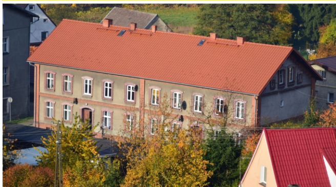
Fot. Dach wyremontowany z budżetu Gminy na budynku komunalnym w Przygórzu.
