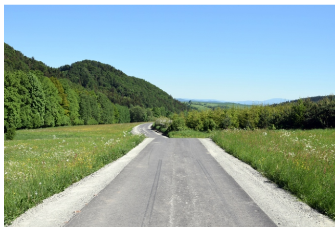
Fot. Nowa nawierzchnia drogi gminnej łączącej Czerwieńczyce z Dzikowcem.
