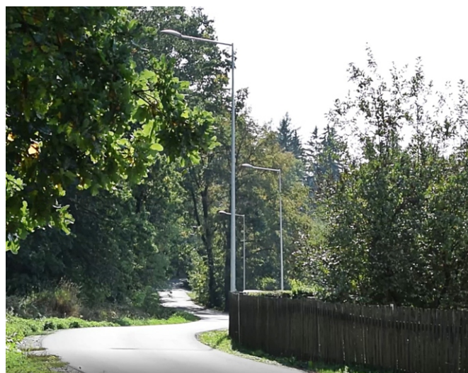
Fot. Gmina zamontowała lampy energooszczędne LED w sołectwie Koszyn, przy drodze powiatowej.
