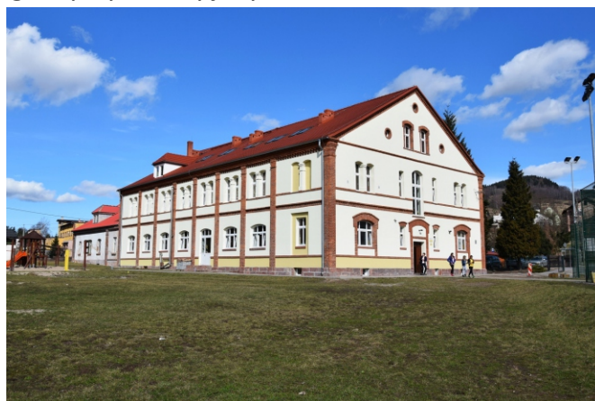
Fot. Budynek szkoły podstawowej w Ludwikowicach Kł. po termomodernizacji.
