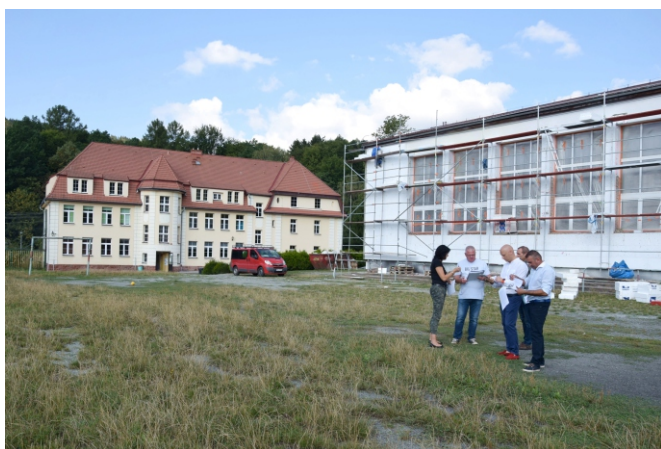
Fot. Podpisanie umowy z wykonawcą, przystępującym do budowy boiska sportowego przy szkole w Jugowie.
