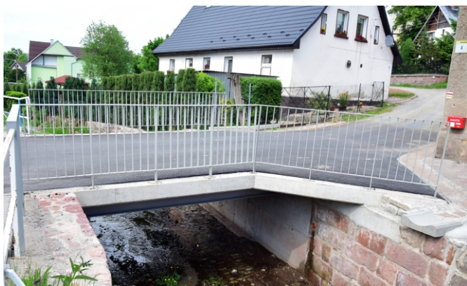
Fot. Wyremontowany most gminny w Świerkach.
