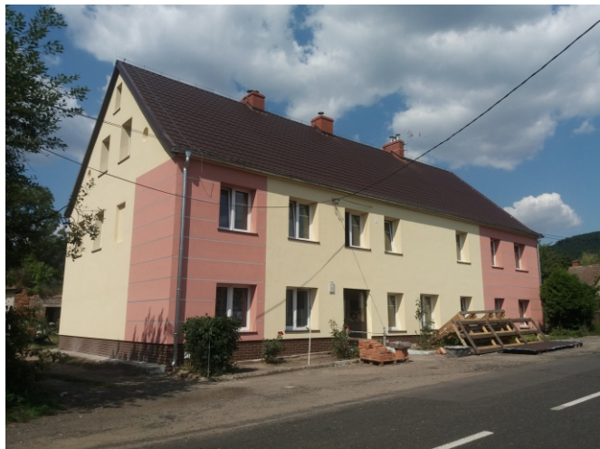
Fot. Budynek komunalny w Woliborzu po przeprowadzonej termomodernizacji.
