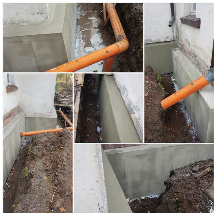
Isolacja i ocieplenie ścian fundamentowych w przedszkolu w Woliborzu. Fot. A. Mierzejewska
