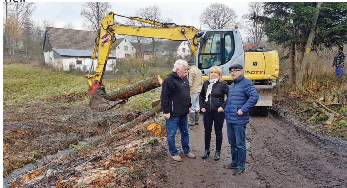
Remont ubezpieczeń brzegowych Woliborki. Fot. P. Szafran
