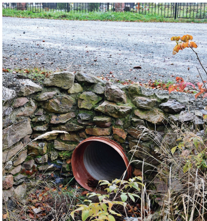
Remont odwodnienia drogi w Przygórzu. Fot. B. Adamska
