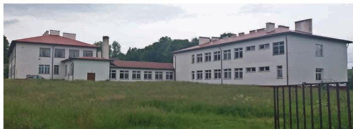
Zespół Szkolno-Gimnazjalny z Oddziałami Integracyjnymi w Bożkowie. W tym miejscu zostania wybudowana sala gimnastyczna Fot. B. Adamska
