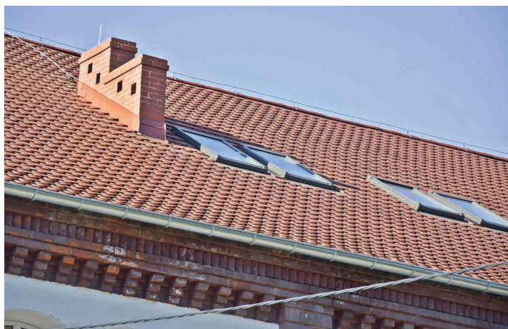
Nowe pokrycie dachowe budynku szkoły podstawowej w Ludwikowicach Kł. Fot. B. Adamska
