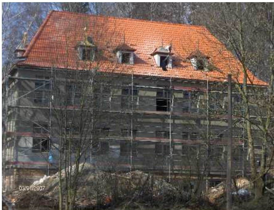
Prace budowlane zewnętrzne
