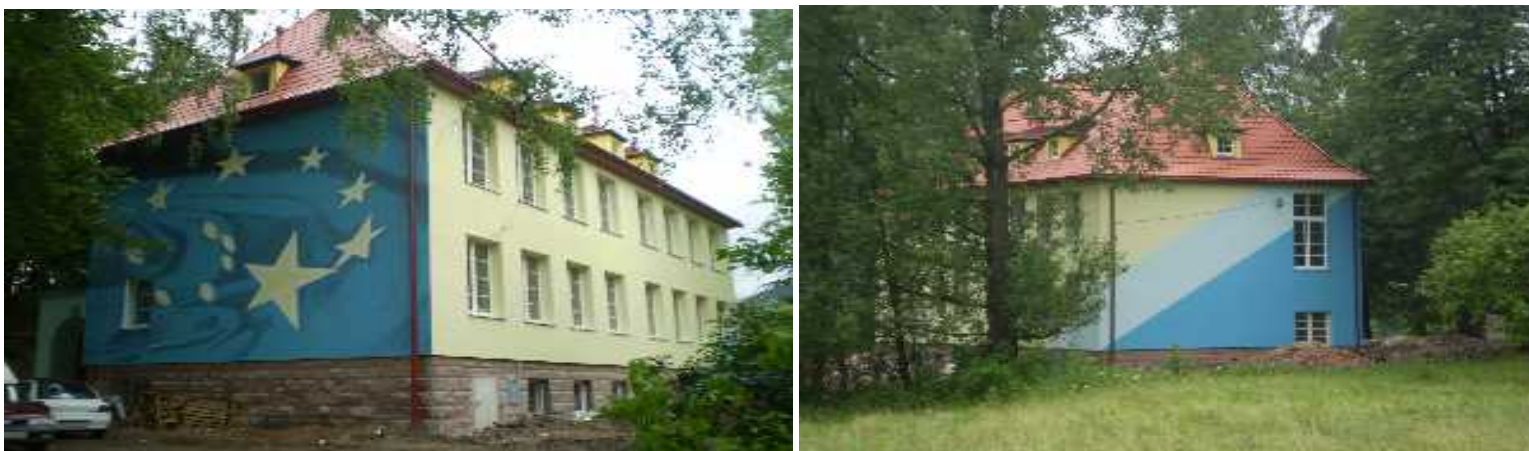
Nowa elewacja na budynku
