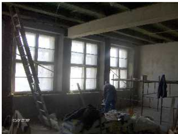
Sala na I piętrze
